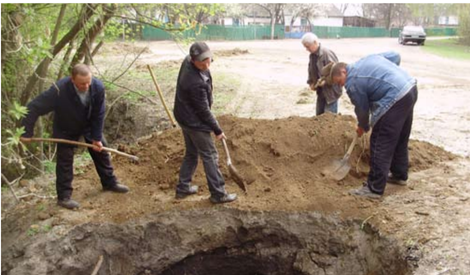
Виконання ремонтно-відновлювальних робіт працівниками Хорольського МУВГ
